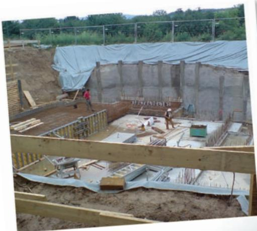
Jedoch besitzt die unterirdische Lage hier gewaltige Vorteile: Der beliefernde LKW kann direkt an die Holzhackschnitzellager, die an der Oberfläche liegen, heranfahren und dorthinein bis zu 216 Kubikmeter Material abkippen. Liegt dann der Brennstoff eine Etage tiefer in dem riesigen Silo, so wird er von dort aus automatisch per Schneckenantrieb weiter bergab in die Kessel transportiert. Ein eindrucksvoller Vorgang, der sich vom Innenraum aus gut beobachten lässt.
